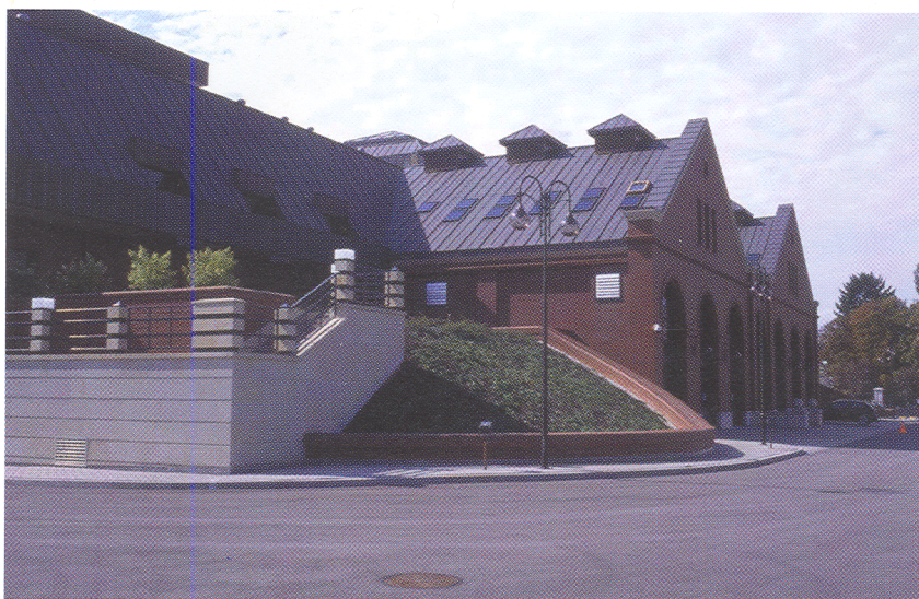
Otsonointi- ja aktiivihiihluodatuslaitos sulautuu hyvin arkkitehtuuriltaan vanhaan rakennuskantaan. Kuva: Katriina Etholén.
