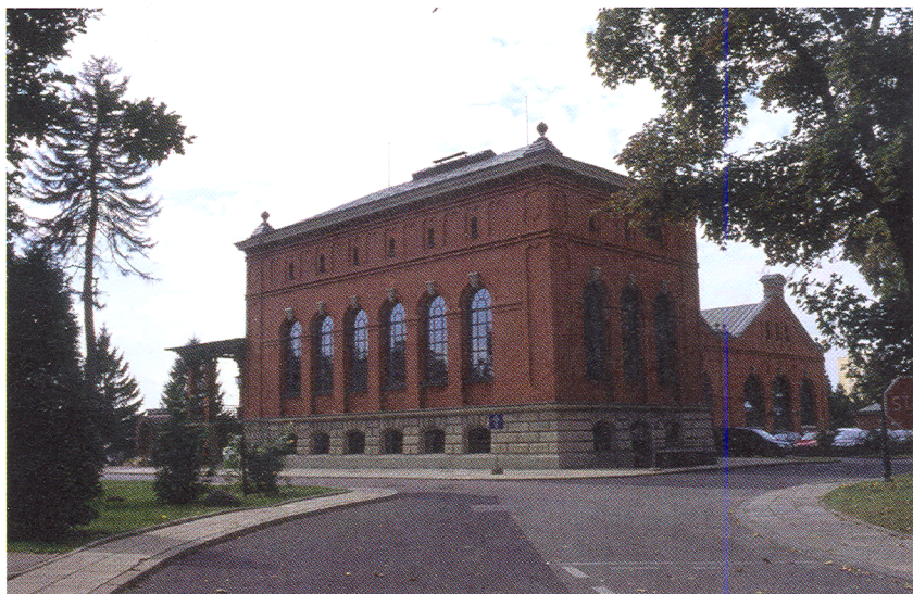
Alkuperäinen pumppuhuone, jossa nykyään sijaitsee vesilaitoksen museo. Kuva: Katriina Etholén.
