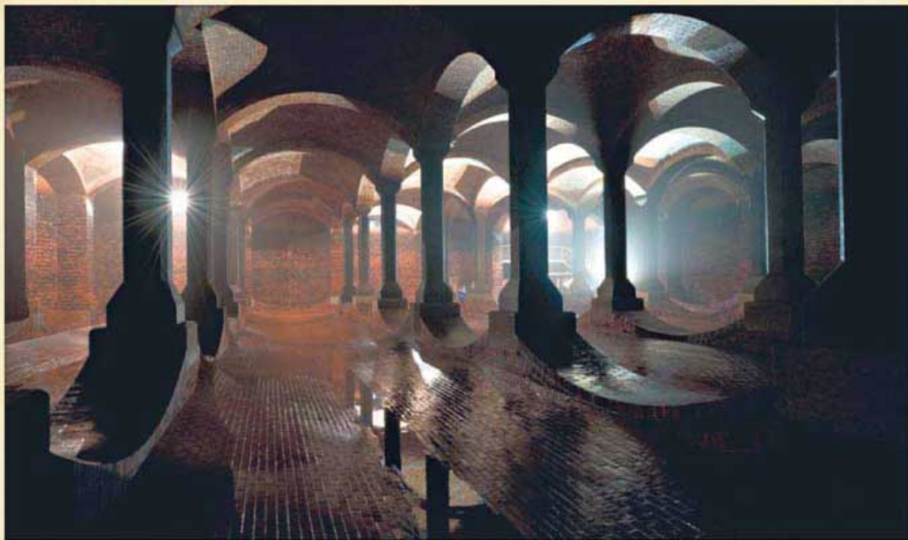
zbiorniki wody czystej
