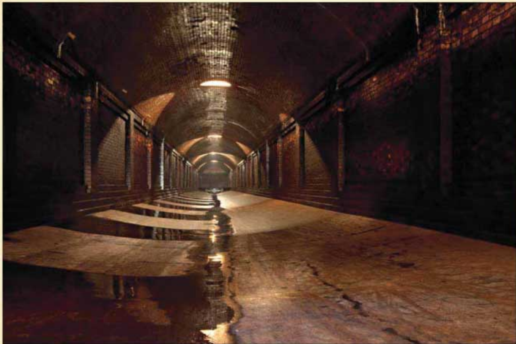
osadniki wody surowej
