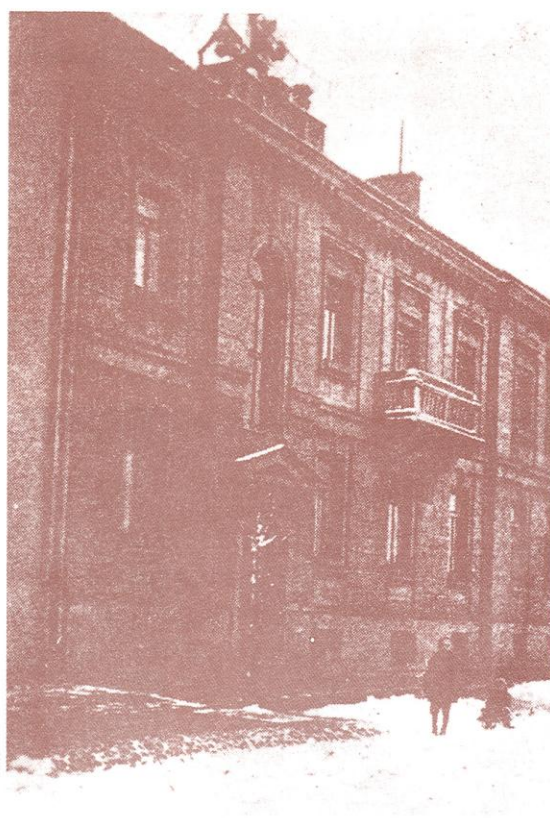
Biura Inspekcji Sieci
