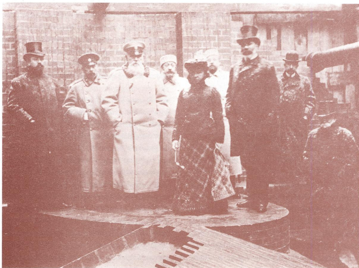
Inspekcja robót (na pierwszym planie, od lewej: J. Lindley, płk Palicyn, tłumaczka, W.H. Lindley oraz A. Grotowski)
