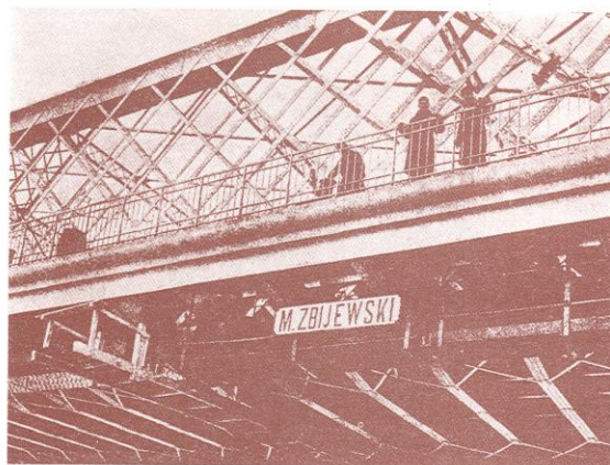
Montowanie przewodów wodociągowych pod mostem Kierbedzia
