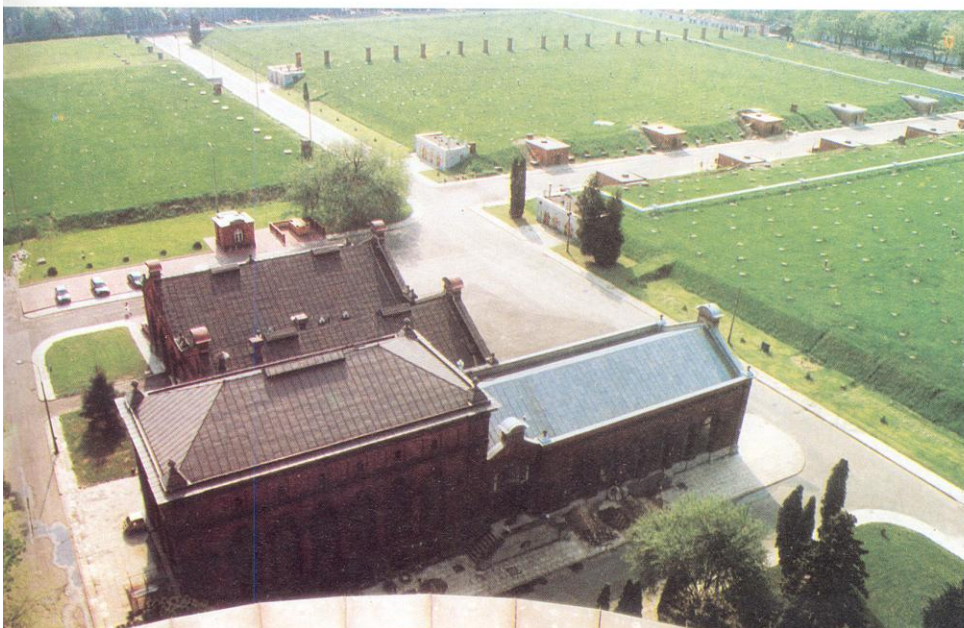
Hale maszyn Dawny budynek mieszkalny pracowników wodociągów Widok z wieży na Stację Filtrów
