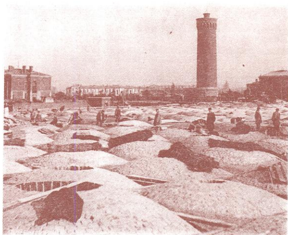
Tynkowanie stropów na filtrach
