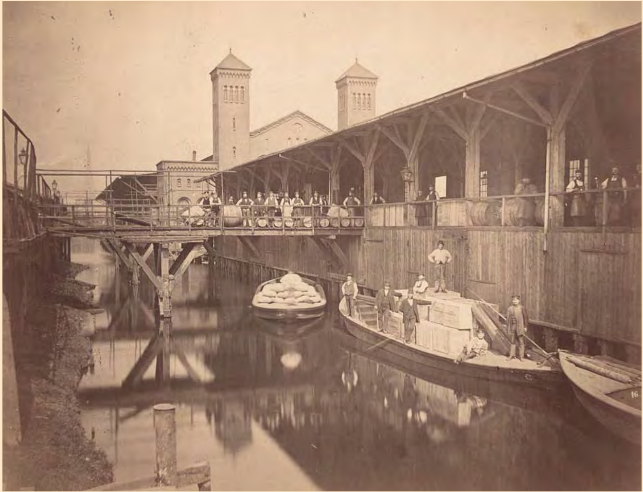
Rautatien tavara-asema Hammerbrookissa Sonninstrassen ja nykyään jo täytetyn kanavan välissä. Kanavien kautta oli yhteys elbeeseen ja toisaalta rautatie yhdisti vesitiet sisämaahan. (Kuva: Staatsarchiv Hamburg)
